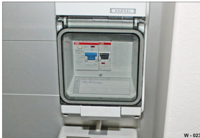
Fig. 23 Boîtier de distribution électrique à l'intérieur
