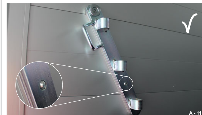
Fig. 117 Rail d'accrochage en place
